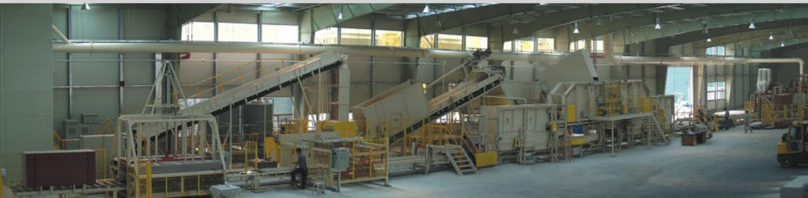
Полностью автоматизированный завод по изготовлению плит из цементного фибролита и EltoBoard
